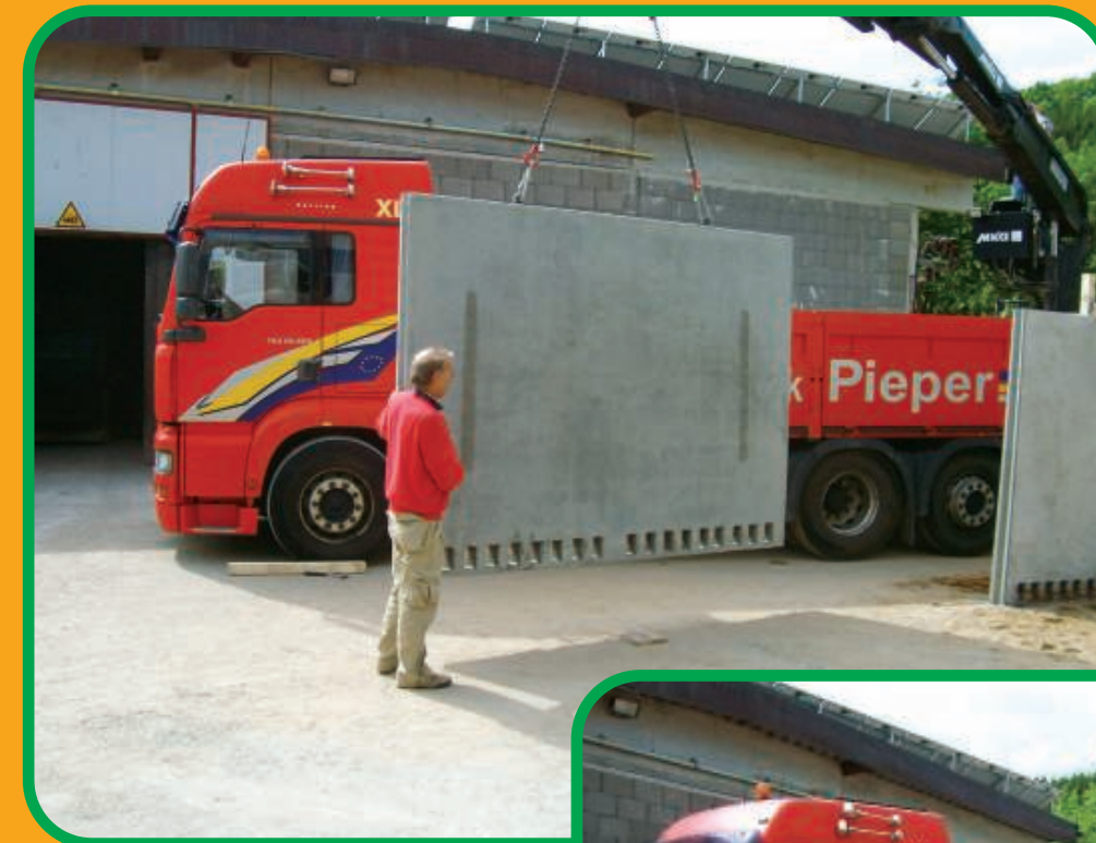
Aufstellen der Betonteile
